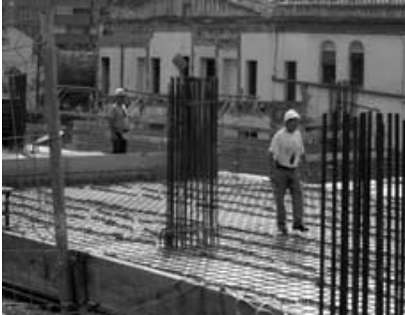
Vue d'un chantier moderne traditionnel (photo C.S.)
