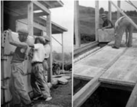
Sur le chantier, tout se réalise à la main (droits réservés)
