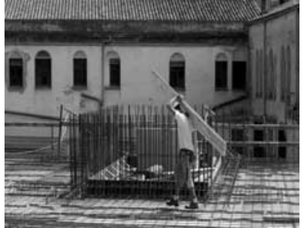
Vue d'un chantier moderne traditionnel (photo C.S.)
