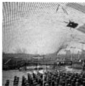
Fig. 15 Mannheim load test
