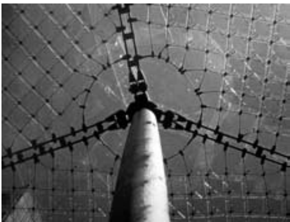
Les tentatives d'industrialisation du bâtiment se sont en général soldées par un échec (droits réservés)
